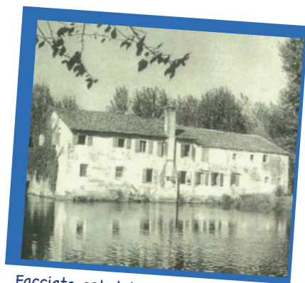
Facciata est del Molino Fabris del XVIII secolo
